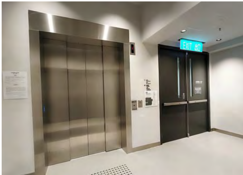
地下升降機大堂
